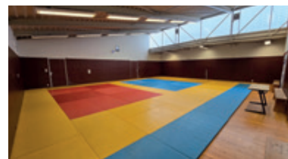
Réfection des panneaux de protection murale à l'intérieur du dojo
